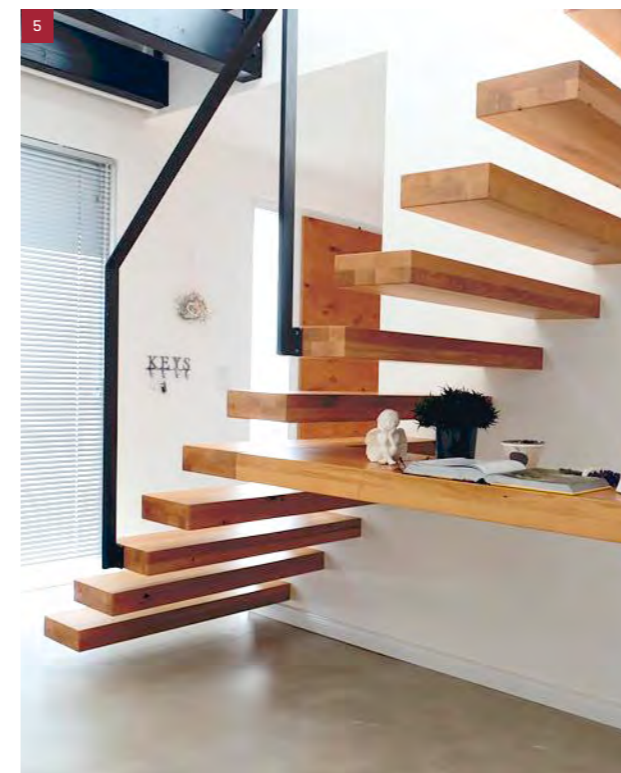
5 Kragarmtreppe in Wildeiche, mit Stahlgeländer und Treppenverlängerung als Tischablage
