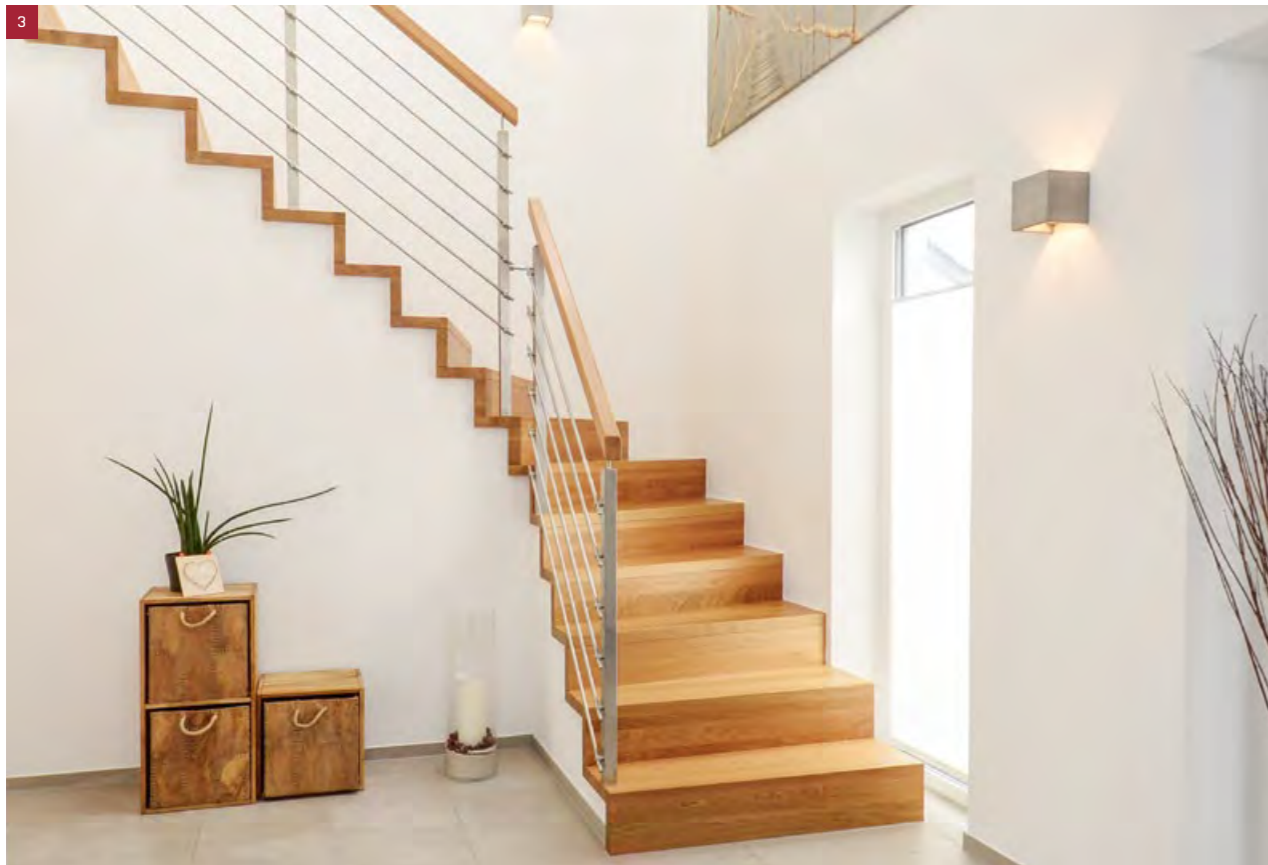
1/4-gewendelte Treppe in Eiche in Faltwerkoptik, quadratische Pfosten und Geländerquerstäbe in Edelstahl, Handlauf eckig
