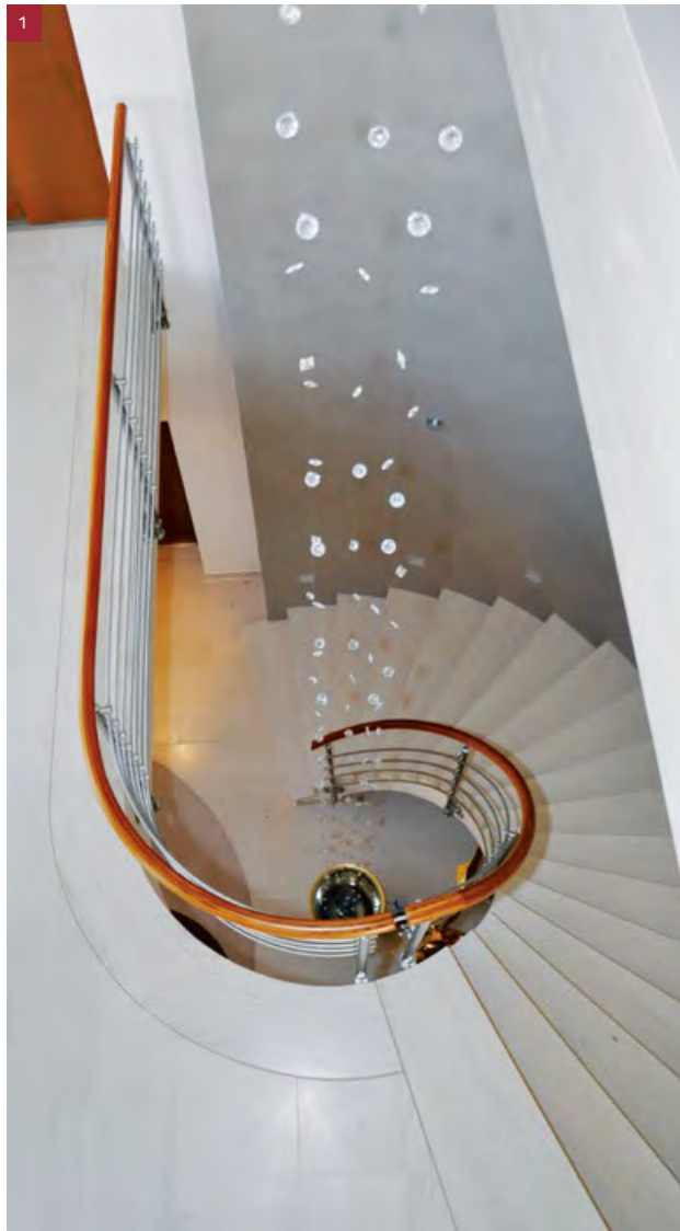
1 Geländer an Betontreppe in amerikanischem Nussbaum, mit Pfosten und Geländerquerstäben in Edelstahl, Rundhandlauf
