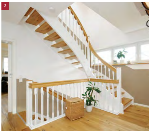
1/4-gewendelte Treppe in Wildeiche. Wangen und Pfosten deckend weiß lackiert. Geländer mit Staketen Nr. 16. Pfosten mit Dachspitzkappe und Ziernuten. Handlauf profiliert
