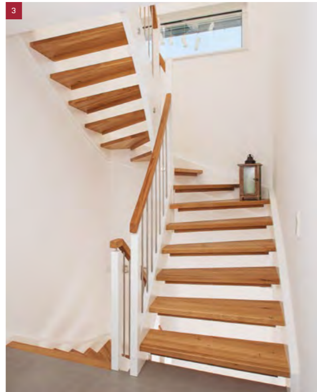
1/2-gewendelte Treppe in Wildeiche, Wangen und Pfosten deckend weiß lackiert, Kinderschutzleisten, senkrechte Geländerstäbe in Edelstahl, Handlauf eckig
