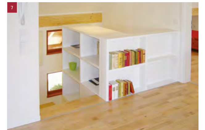
7 Treppen- und Brüstungsregal deckend weiß lackiert
