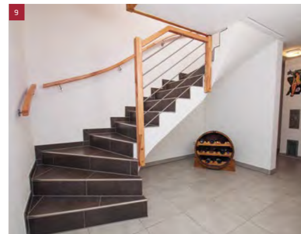
9 Geländer an Betontreppe in Buche keilgezinkt bunt, Geländerquerstäbe in Edelstahl, Handlauf eckig
