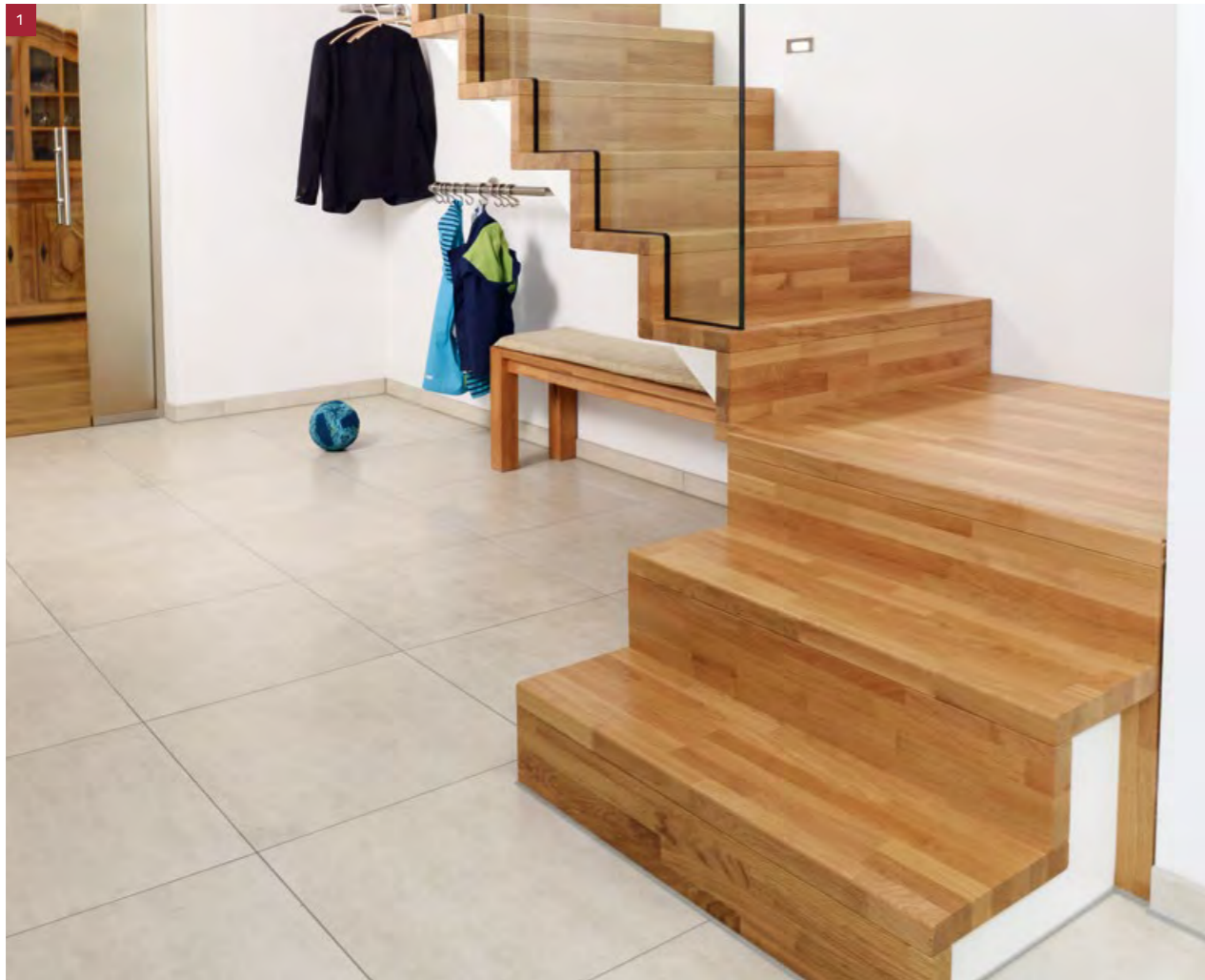
Treppe mit Antrittspodest in Eiche keilgezinkt in Falwerkoptik. Wangen deckend weiß lackiert. Glasgeländer
