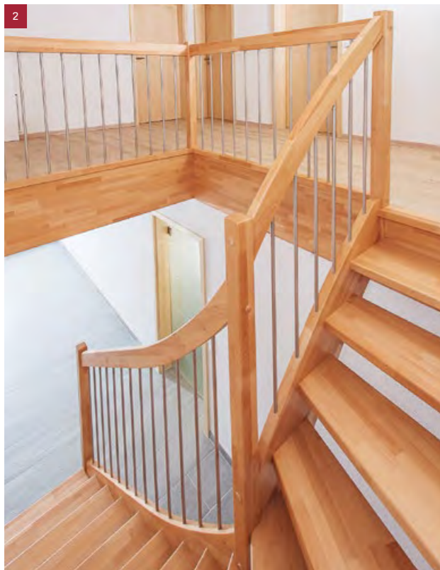
1 Brüstungsgeländer in Buche keilgezinkt, mit eingetutetem Glas. Kinderschutztür mit senkrechten Geländerstäben in Edelstahl, Rundhandlauf
