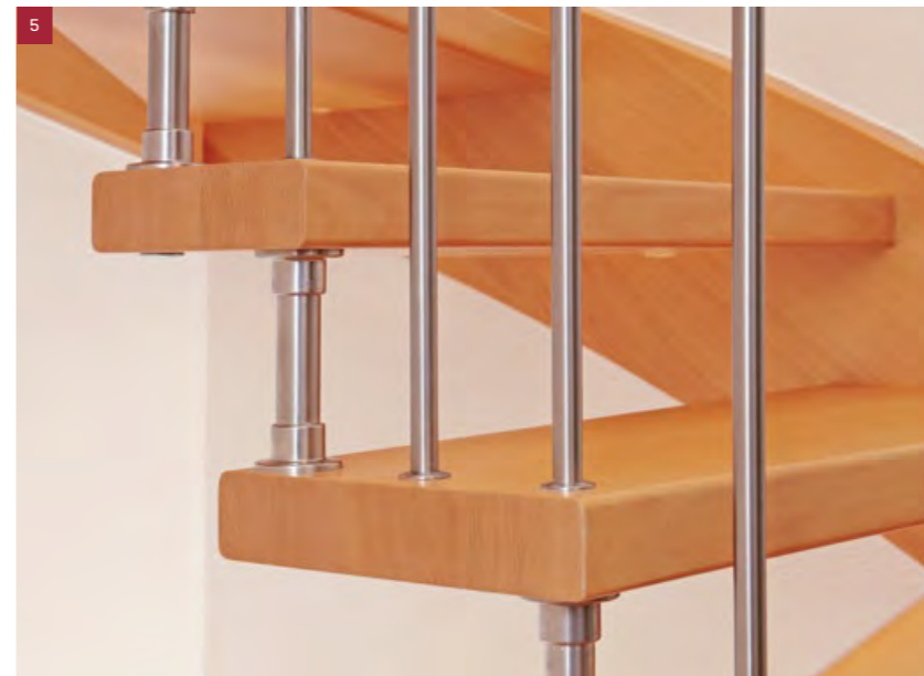
5 Detailansicht Stufenbolzen und senkrechte Geländerstäbe in Edelstahl
