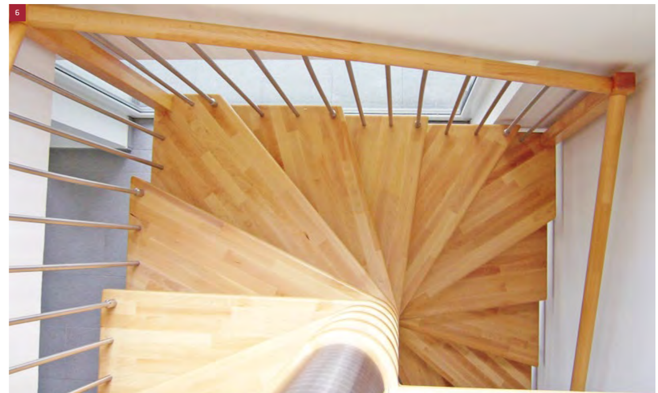
6 Detailansicht Treppenaufgang (Spindeltreppe mit quadratischem Grundriss in Buche keilgezinkt)
