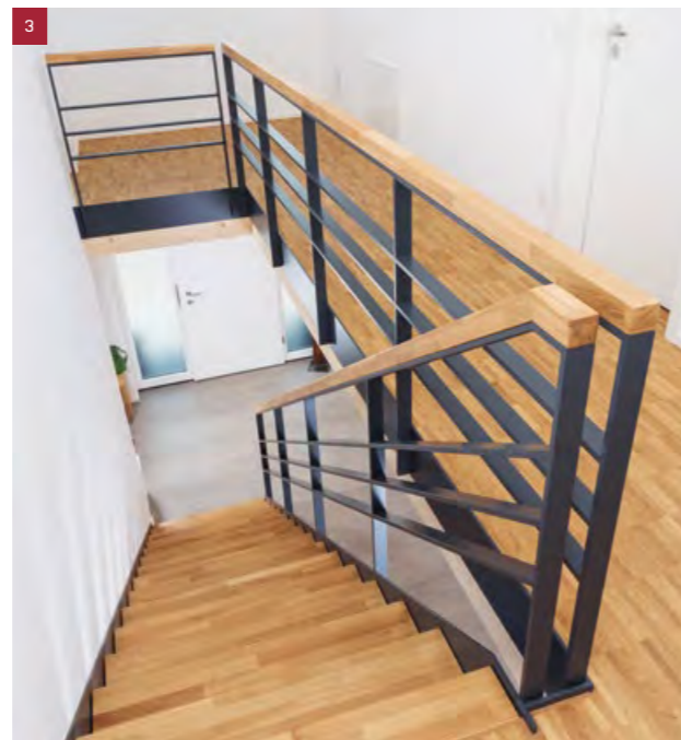
Detailansicht Brüstungs- und Treppengeländer (Stahlwangentreppe mit Stufen in Eiche keilgezinkt)
