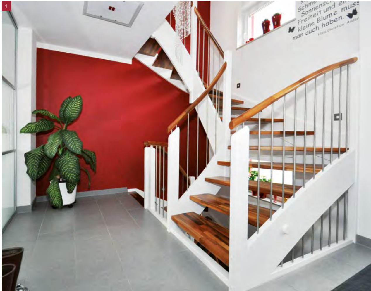
2x1/4-gewendelte Treppe in Nussbaum keilgezinkt, Wangen und Pfosten deckend weiß lackiert, senkrechte Geländerstäbe in Edelstahl, Rundhandlauf
