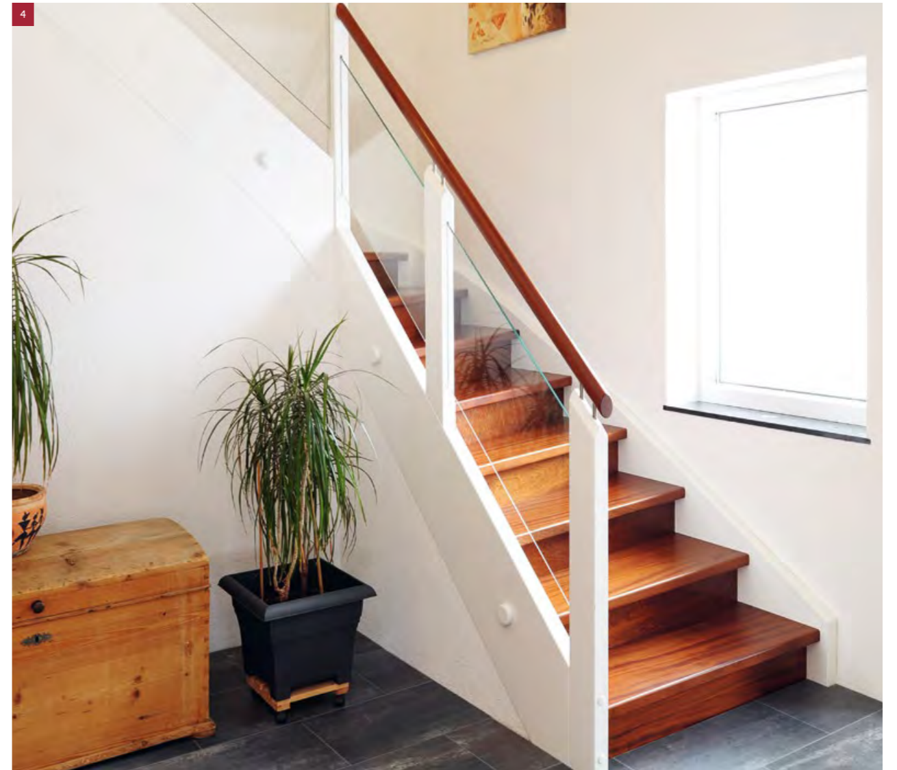
1/4-gewendelte Treppe in Mahagoni. Wangen und Pfosten deckend weiß lackiert. Geländer mit eingetutetem Glas. Rundhandlauf
