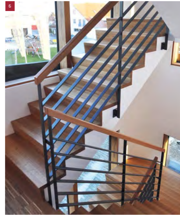
6 Stufen und Setzstufen auf Betontreppe in Eiche, Flachstahlgeländer, Handlauf eckig
