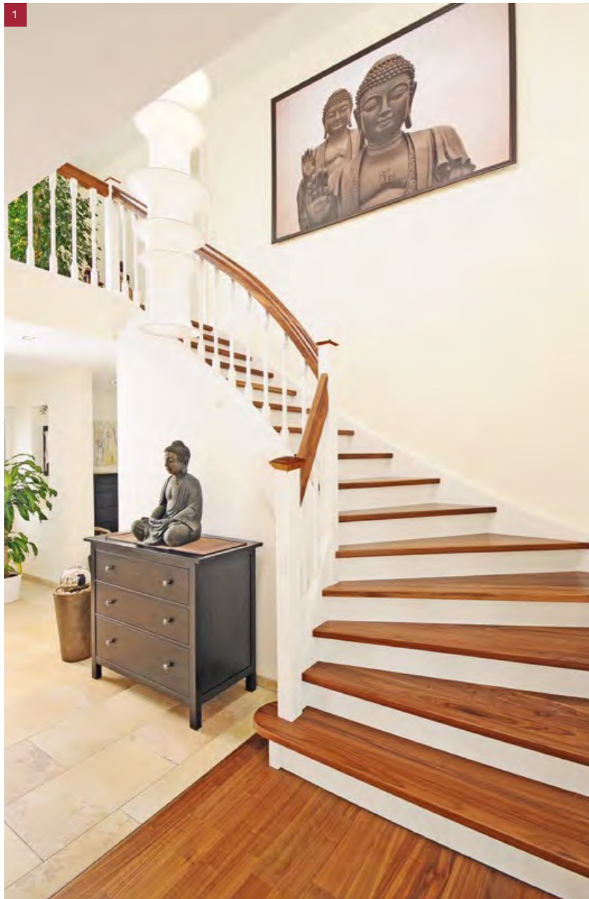
1/4-gewendelte Treppe in amerikanischem Nussbaum. Wangen, Pfosten und Setzstufen deckend weiß lackiert. Geländer mit Staketen Nr. 16. Pfosten mit aufgesetzter Profilkappe, Hohlkeule und Ziernuten, Handlauf profiliert
