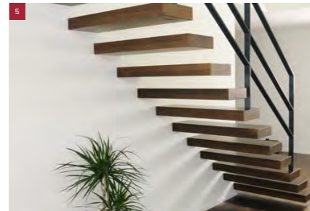
Detailansicht Treppenrückseite (Kragarmtreppe in Buche gebeizt)
