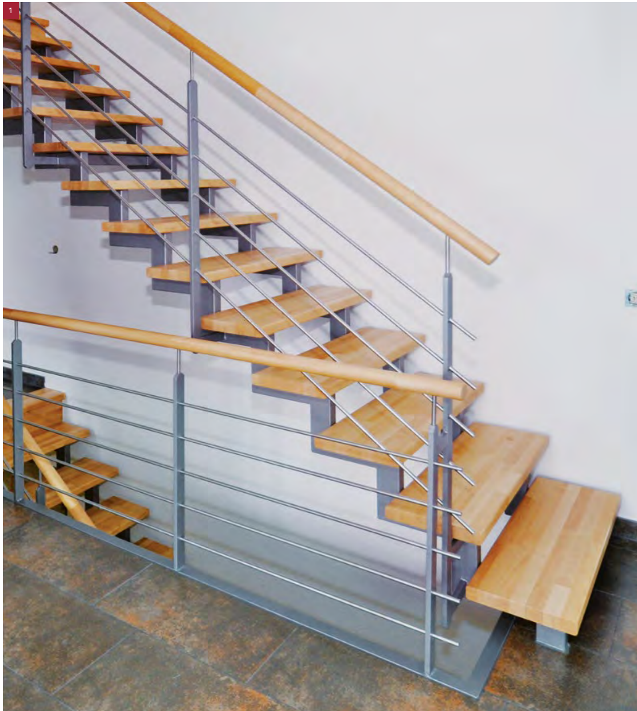
Stahlholmtreppe mit Stufen in Buche keilgezinkt. Geländer mit Flachstahlpfosten und Geländerquerstäben in Edelstahl. Rundhandlauf
