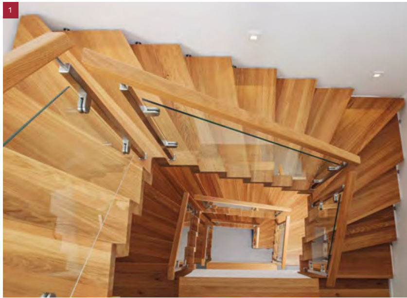
1 Detailansicht Treppenaufgang (2x1/4-gewendelte Faltwerkterre in Eiche)
