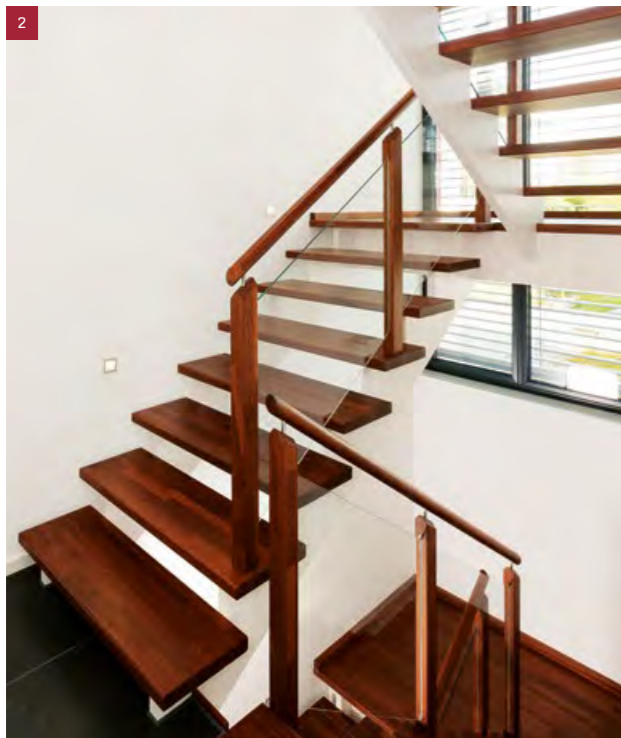
Treppe mit Zwischenpodest in Mahagoni. Wangen weiß pigmentiert. Geländer mit eingetutetem Glas. Rundhandlauf
