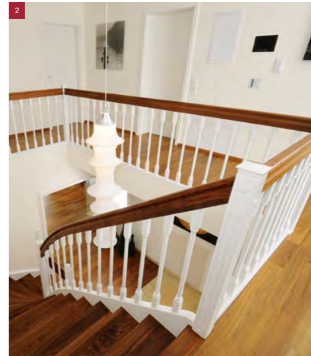
Brüstungsgeländer in amerikanischem Nussbaum, Pfosten mit aufgesetzter Dachspitzkappe und Hohlkehle. Staketen Nr. 16 und Bodensohle deckend weiß lackiert. Handlauf profiliert
