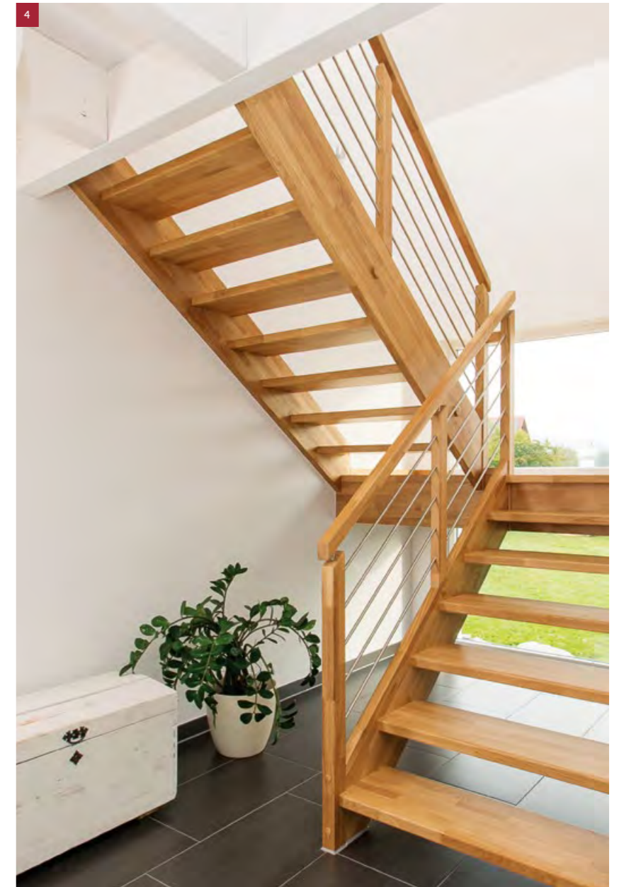
Treppe mit Zwischenpodest in Eiche keilgezinkt, Geländerquerstäbe in Edelstahl, Handlauf eckig
