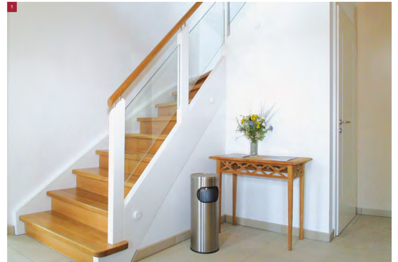
Kellerabgang mit Wandverkleidung
