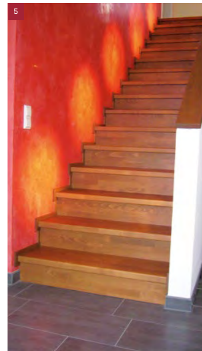
5 Stufen und Setzstufen auf Betontreppe in Buche gebeizt, mit Wandanschlussleisten und Wandabdeckbrett
