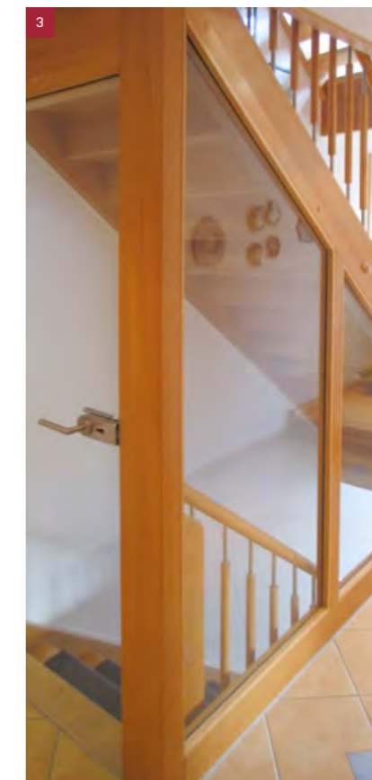
Kellerabgang mit Glasverkleidung
