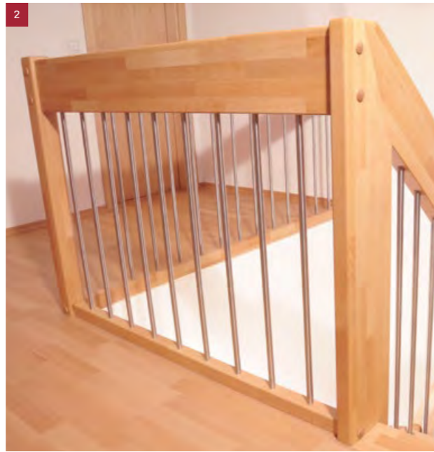
Detailansicht Brüstungsgeländer (1/2-gewendelte Bolzentreppe in Buche keilgezinkt)
