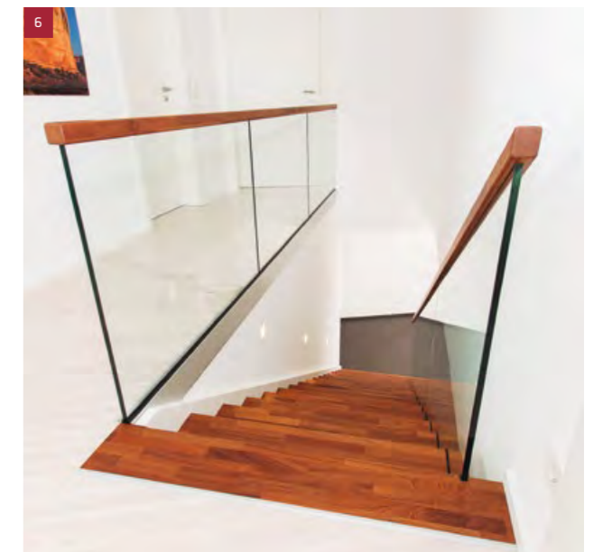
Detailansicht Brüstungsgeländer Glas (Gerade Treppe in Mahagoni keilgezinkt)
