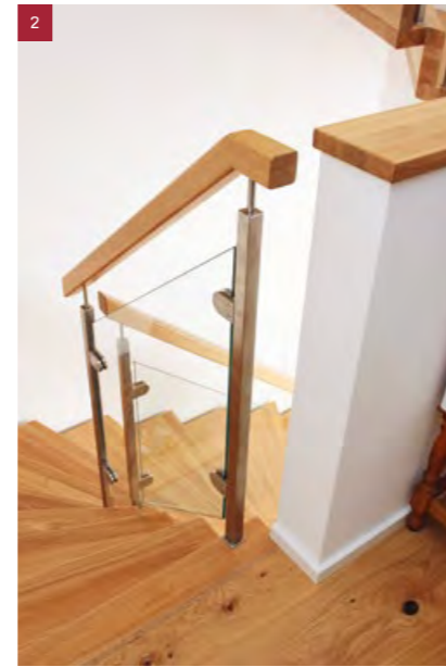
2 Detailansicht oberer Treppenaustrittsbe- reich und Brüstungswand mit Abdeckbrett (2x1/4-gewendelte Faltwerkterre in Eiche)
