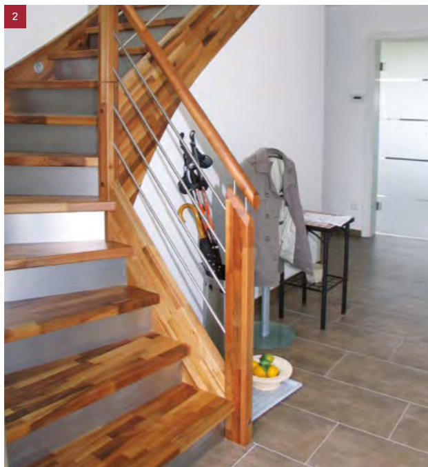
1/4-gewendelte Treppe in Nussbaum keilgezinkt. Setzstufen in Edelstahloptik. Geländerquerstäbe in Edelstahl. Rundhandlauf
