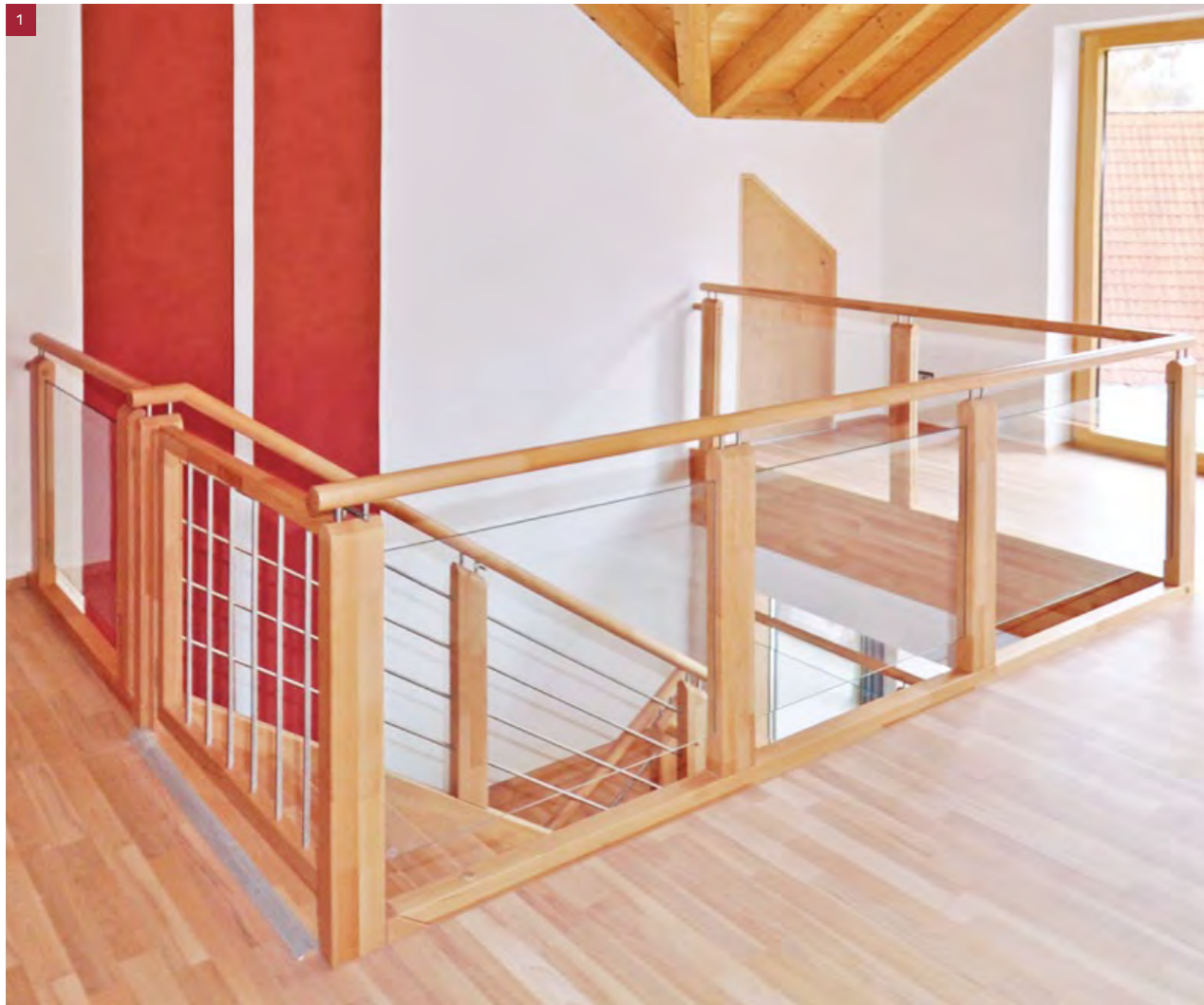
1 Brüstungsgeländer in Buche keilgezinkt, mit eingetutetem Glas. Kinderschutztür mit senkrechten Geländerstäben in Edelstahl, Rundhandlauf
