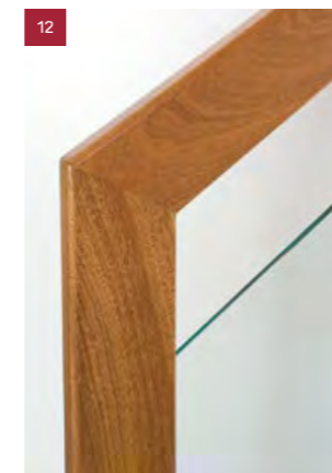
12 Pfosten 43 / 100 mm handlaufgleich als Rahmen verleimt
