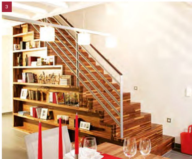
Faltwerkteresse in Nussbaum keilgezinkt. Wangen verdeckt durch Regal- und Kellerabgangsverkleidung
