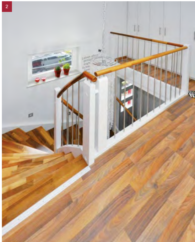
Detailansicht Brüstungsgeländer (2x1/4-gewendelte Treppe in Nussbaum keilgezinkt)
