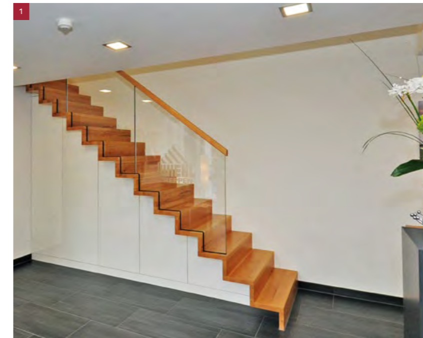
Einbauschränk abgetreppt unter Treppenstufen mit Hochglanzfronten in weiß und Tip-On Beschlag
