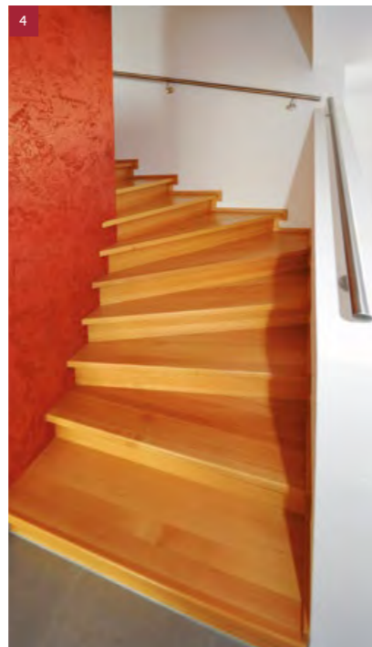
4 Stufen und Setzstufen auf Betontreppe in Buche, mit Wandanschlussleisten, Wandhandlauf in Edelstahl
