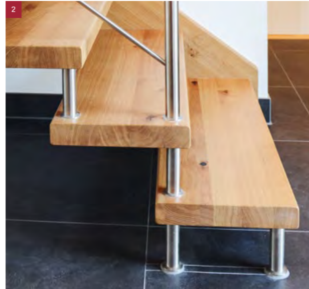
Detailansicht Stufenbolzen in Edelstahl (Gerade Bolzentreppe in Wildeiche)
