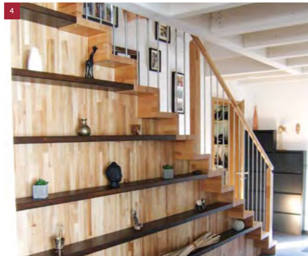
Treppenregalwand unter Treppe
