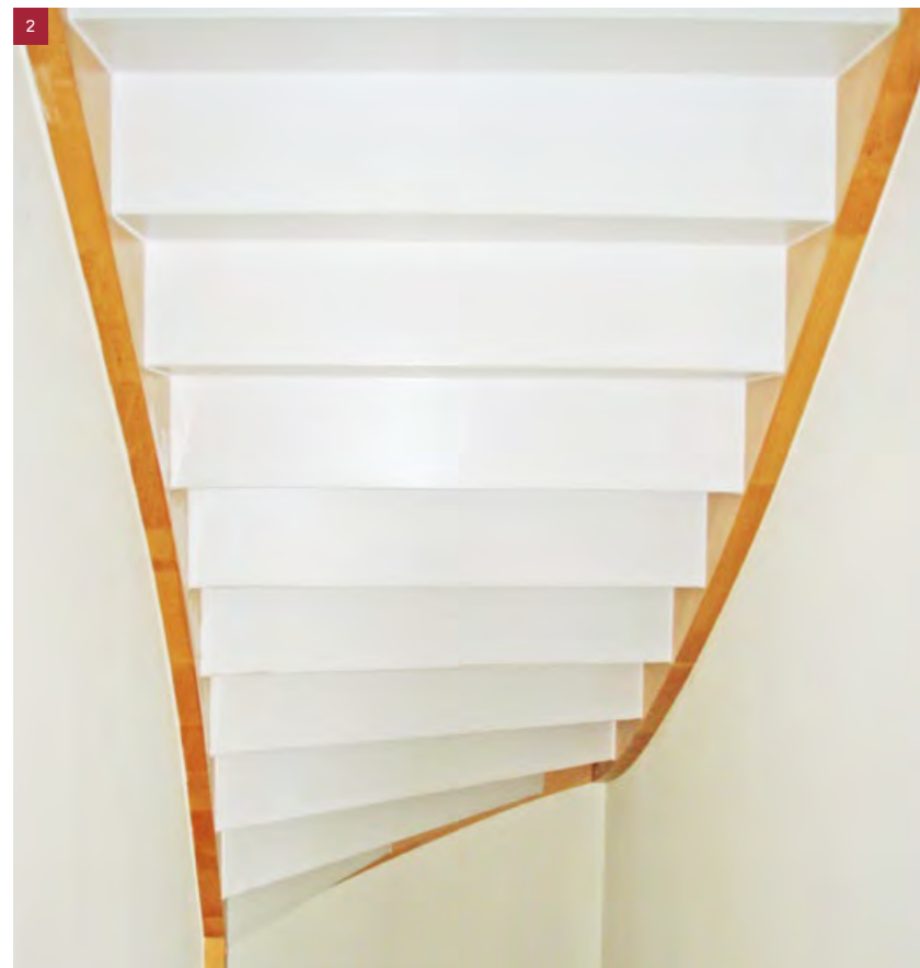
Unterseitige Treppendämmung werkseitig angebracht bei Modultreppen bzw. in fertigem Zustand
