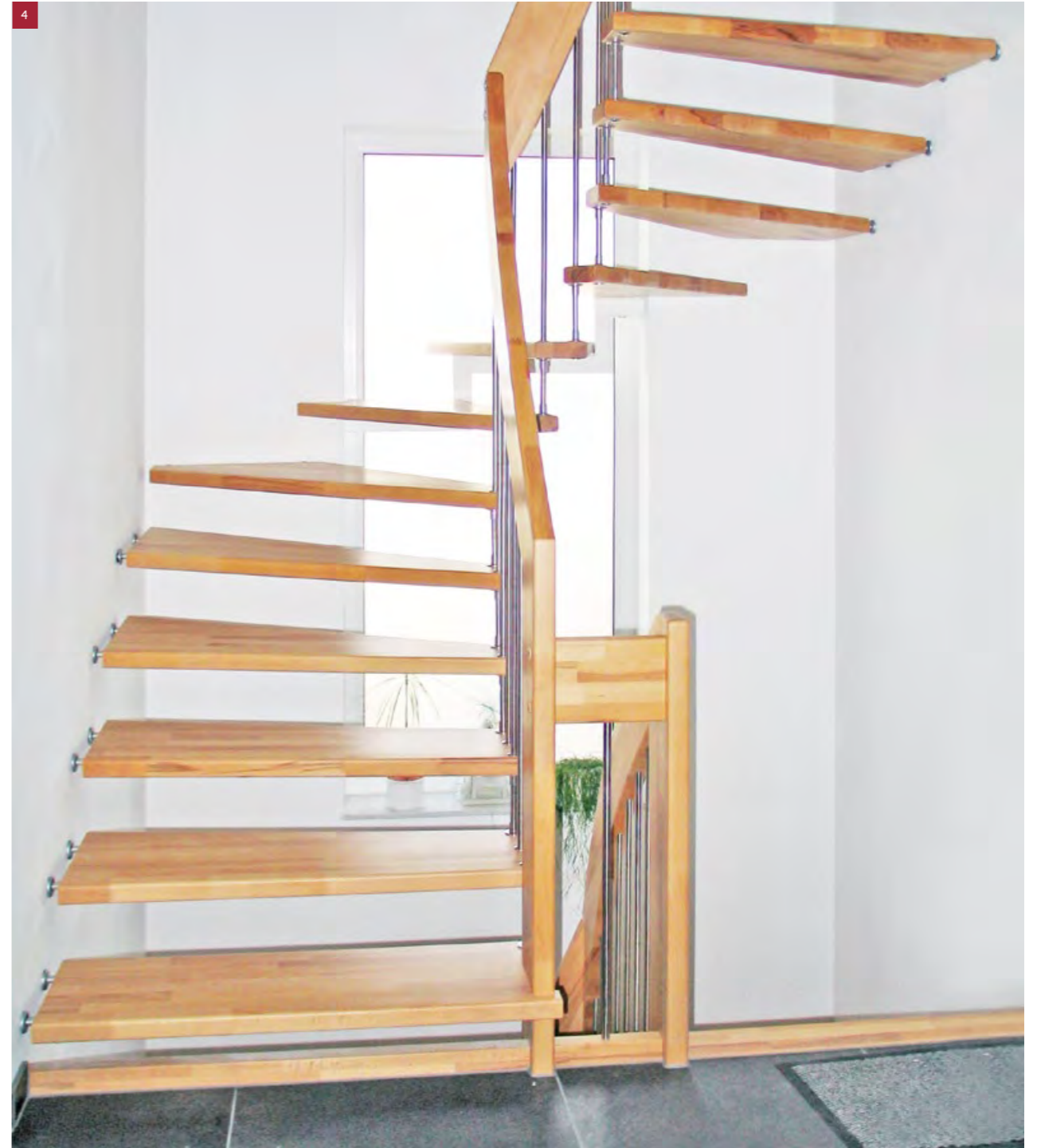
4 1/2-gewendelte Bolzentreppe in Buche keilgezinkt, senkrechte Geländerstäbe in Edelstahl, mit Stahlwangenübergang im Fensterbereich, Pfosten und Handlauf eckig
