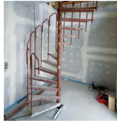
Bautreppe von Wiehl für die Rohbauphase
