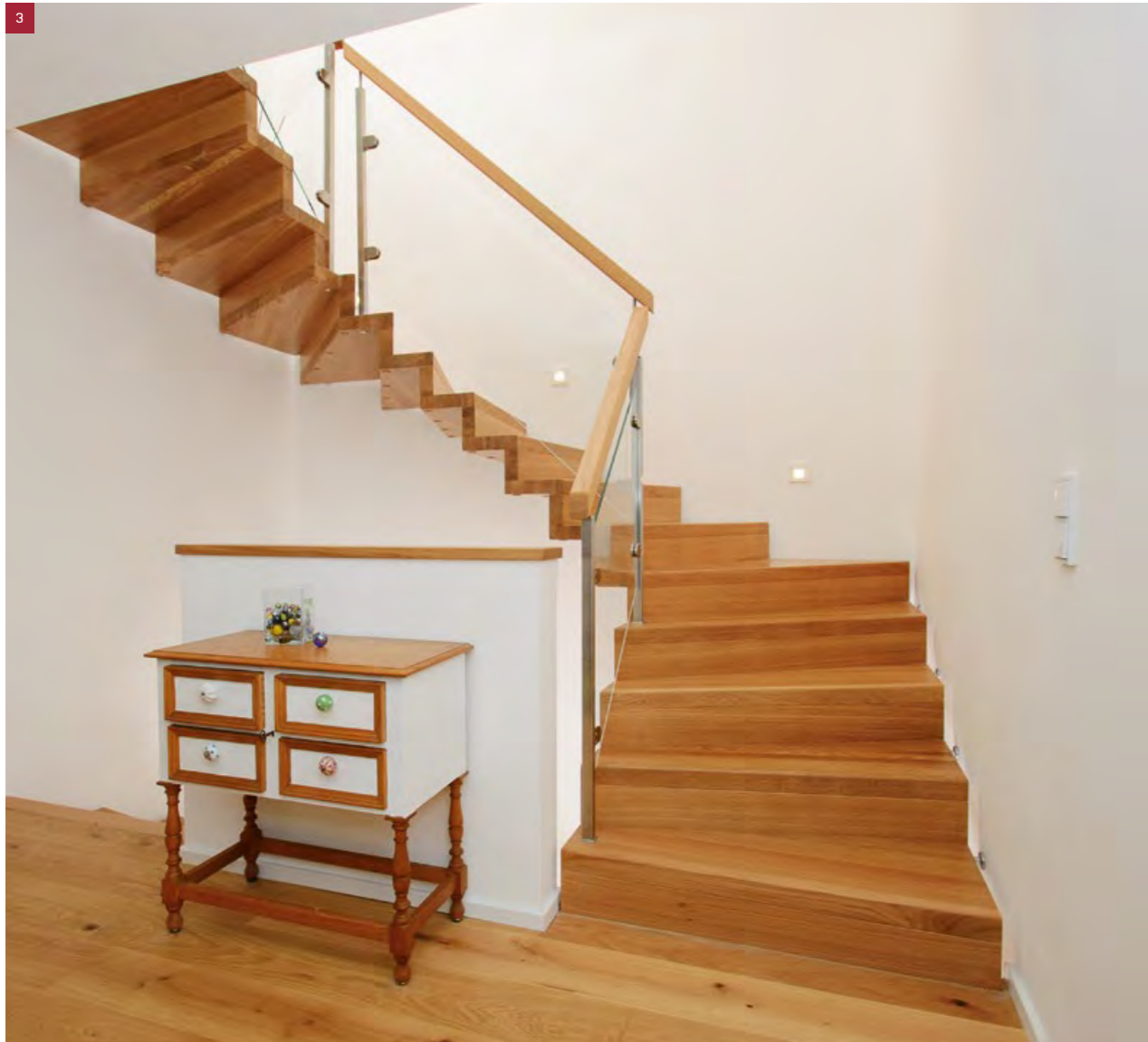
3 2x1/4-gewendelte Faltwerkterre in Eiche, quadratische Pfosten in Edelstahl. Glasgeländer mit Glashalter, Handlauf eckig
