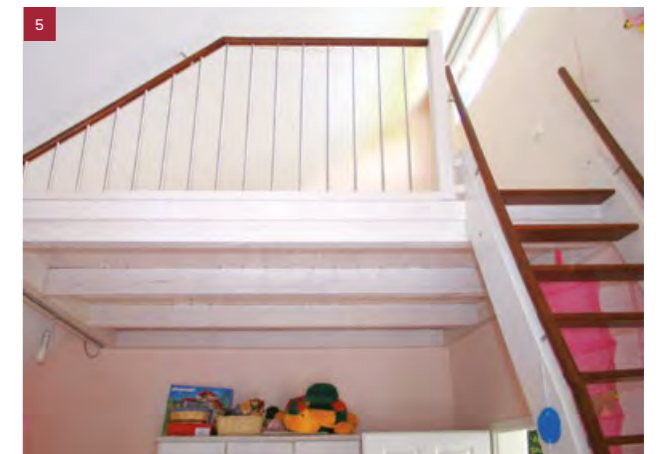
Detailansicht Brüstungsgeländer in Dachschräge (Leitertreppe zum Rückwärtsbegehen in Mahagoni)
