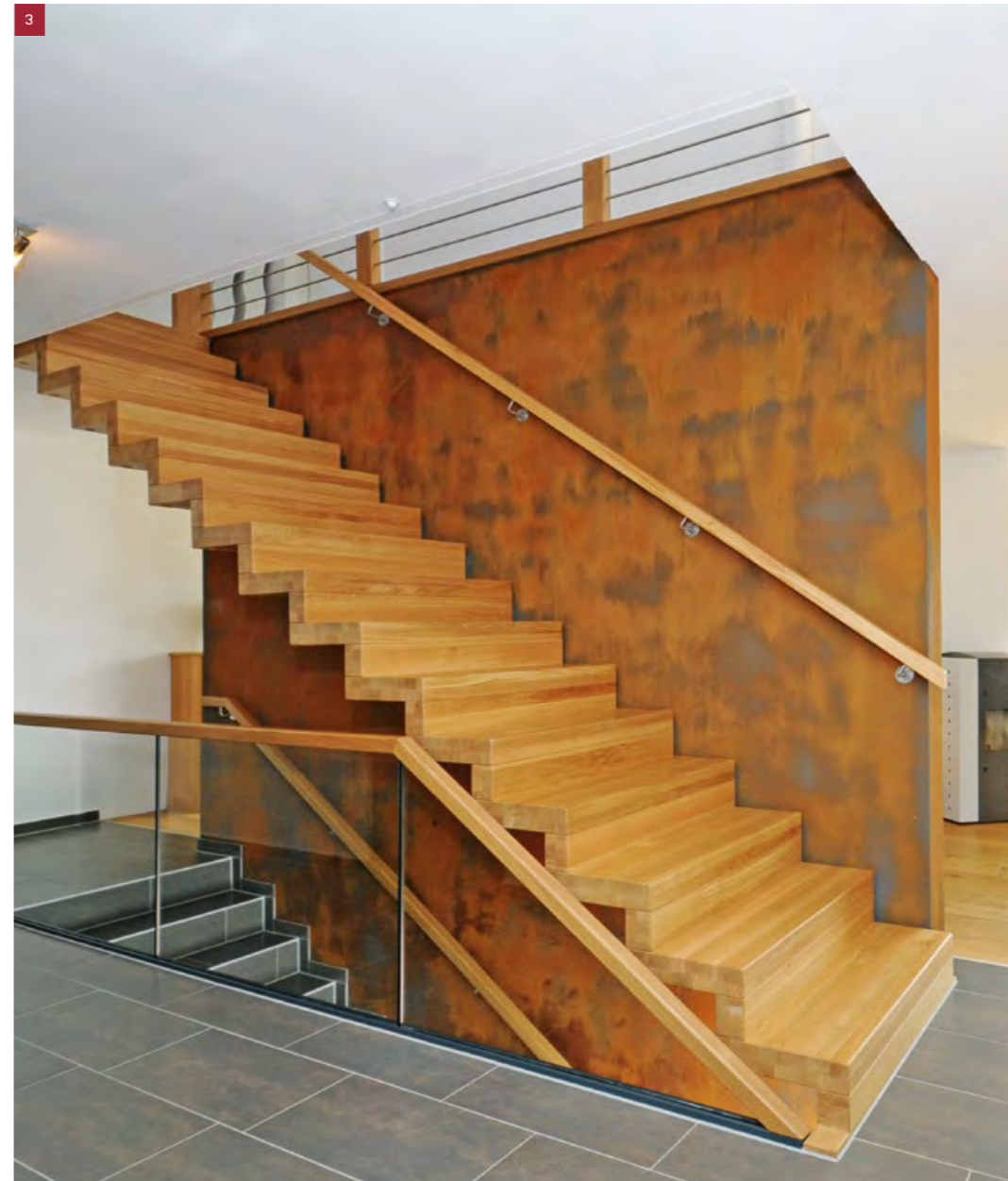
3 Gerade Falwerktrappe in Eiche. Brüstungsgeländer Glas. Wandhandlauf eckig
