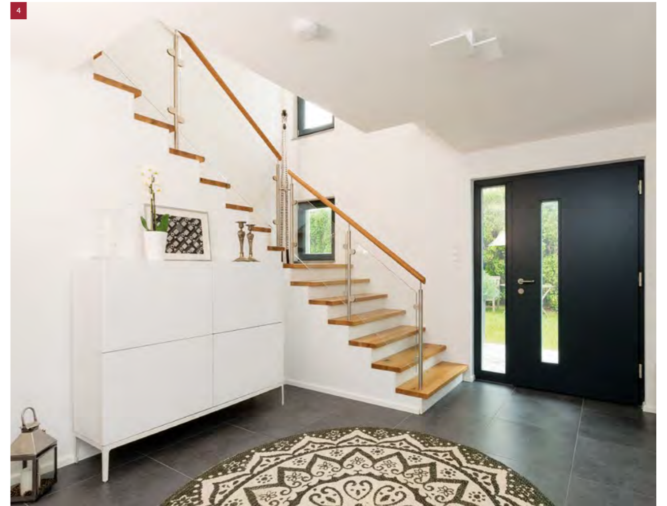
Treppe mit Eckpodest in Wildeiche. Setzstufen deckend weiß lackiert. Pfosten in Edelstahl. Glasgeländer mit Glashalter. Rundhandlauf
