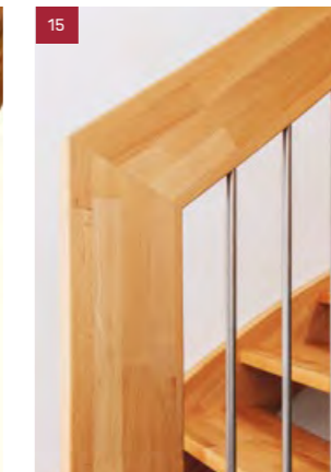
15 GT-Pfosten 43 / 170 mm handlaufgleich als Rahmen verleimt, für geländertragende Treppen
