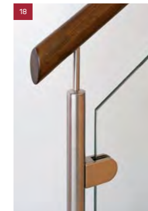
18 Edelstahlpfosten mit Glashalter und Handlaufstütze
