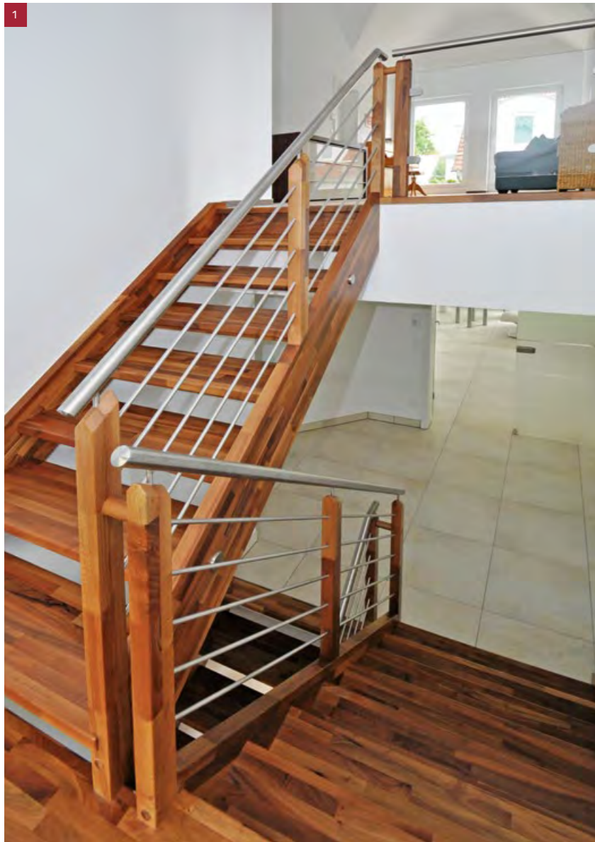
Podesttreppe in Nussbaum keilgezinkt. Geländerquerstäbe und Rundhandlauf in Edelstahl
