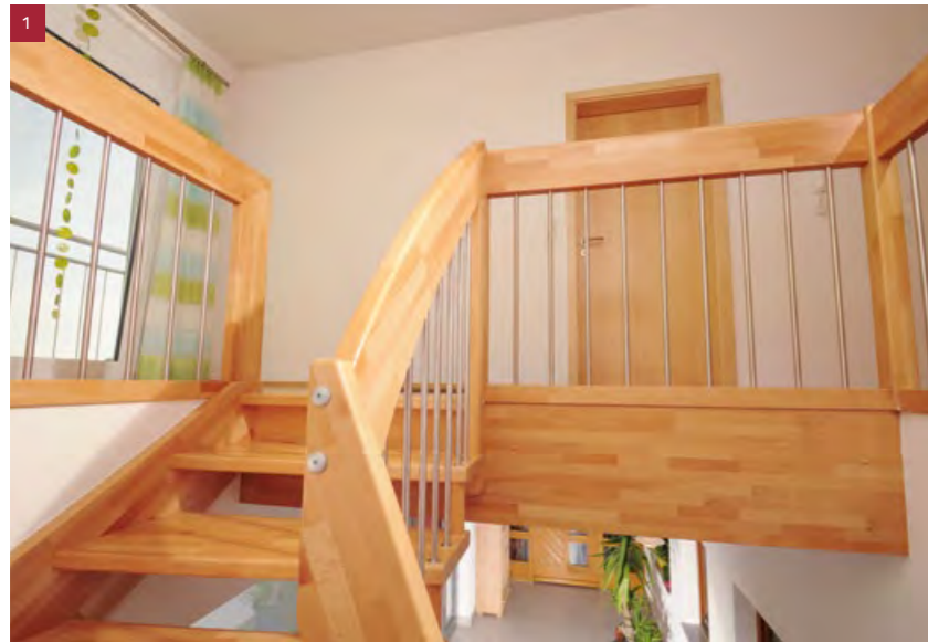
Ausführung mit Deckenstirnverkleidung in gleicher Holzart wie Treppe
