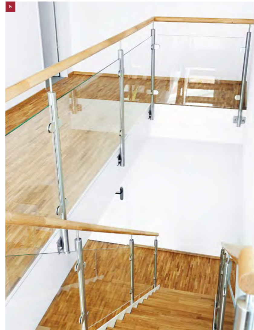
Stahlwangentreppe mit Stufen in Eiche keilgezinkt, Glasgeländer mit Glashalter und Pfosten in Edelstahl, Rundhandlauf
