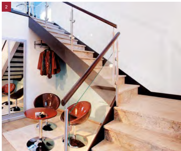
Stahlwagentreppe mit Granitstufen. Pfosten in Edelstahl. Glasgeländer mit Glashalter. Rundhandlauf
