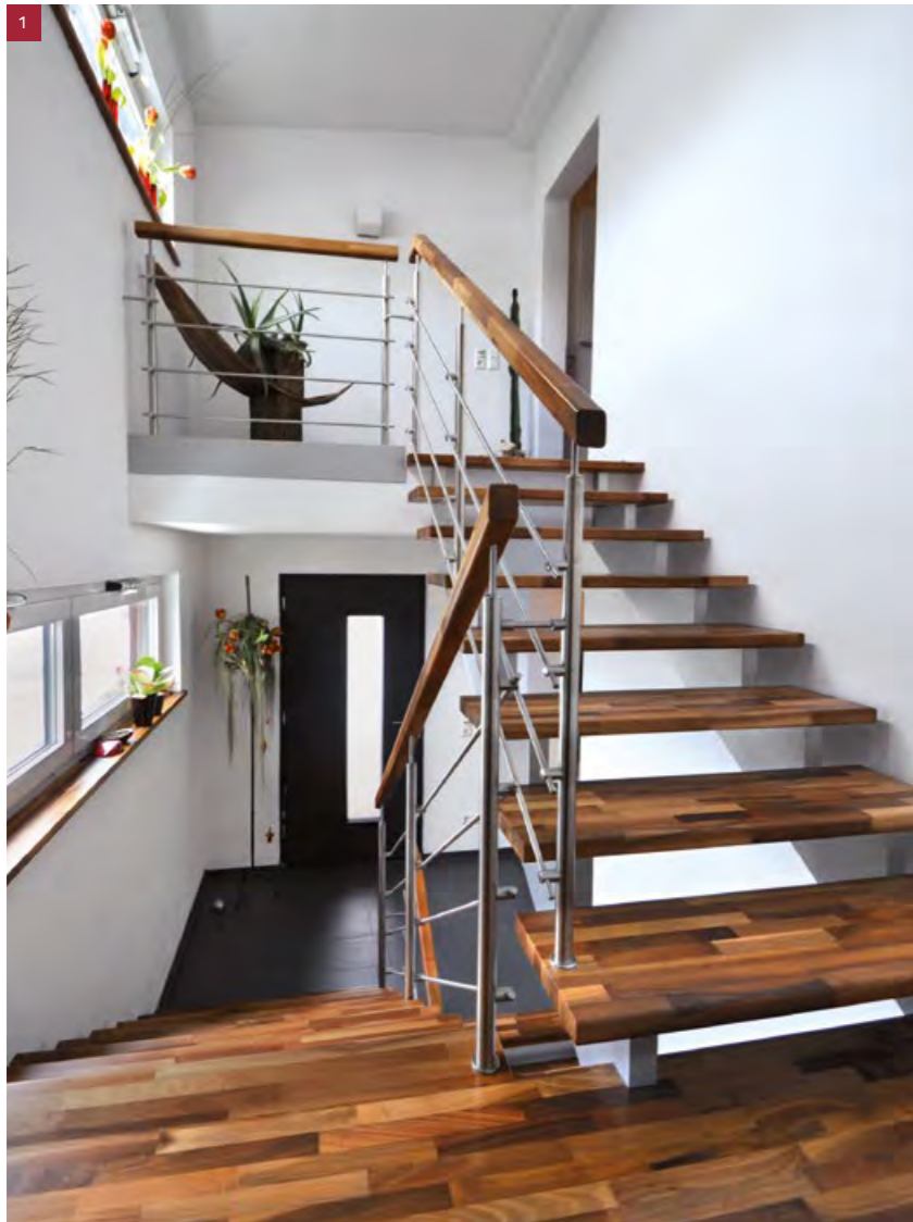
Podesttreppe in Nussbaum keilgezinkt. Wangen deckend farbig lackiert. Pfosten und Geländerquerstäbe in Edelstahl. Handlauf eckig
