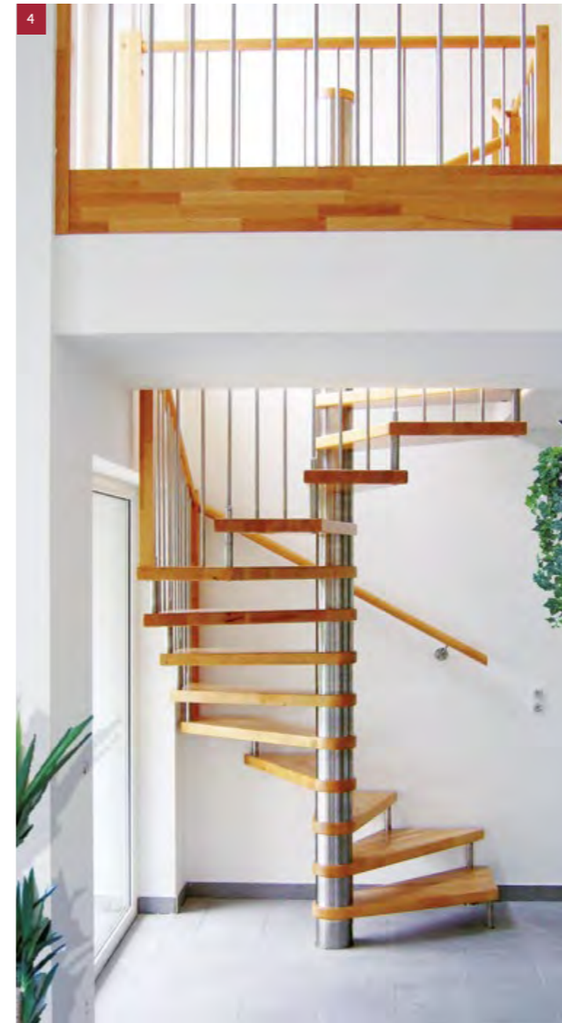
5 Spindeltreppe mit quadratischem Grundriss in Buche keilgezinkt. Spindel, Stufenbolzen und senkrechte Geländerstäbe in Edelstahl. Rundhandlauf
