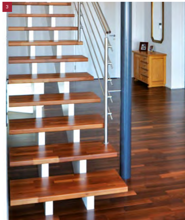
Gerade Treppe in Nussbaum keilgezinkt. eingerückte Wangen deckend weiß lackiert. Geländer in Edelstahl
