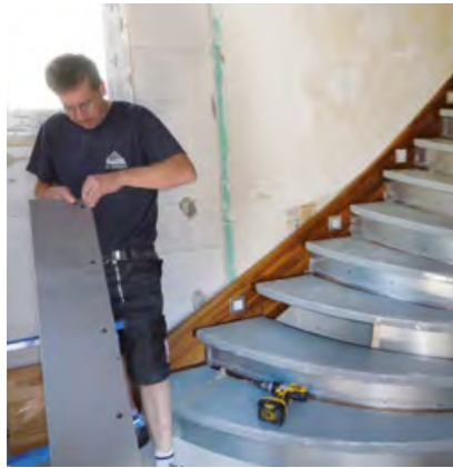
Treppenmontage in Einzelteilen mit Stufen und Schutzabdeckungen
