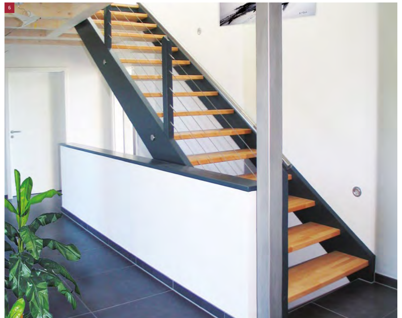
Gerade Treppe in Buche keilgezinkt. Wangen und Pfosten deckend farbig lackiert. Geländerfüllung mit Edelstahlseilen. Rundhandlauf in Edelstahl
