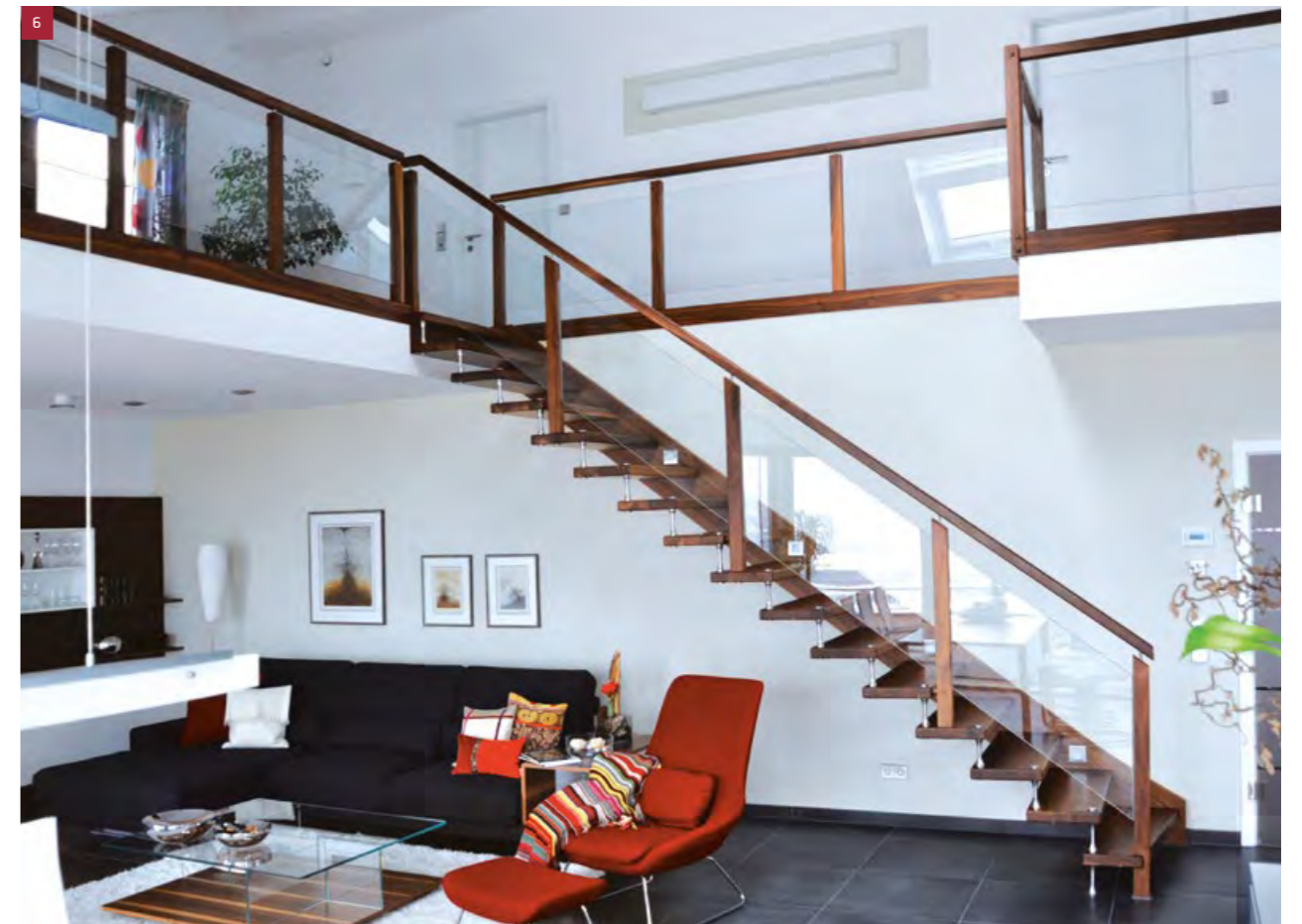
Gerade Bolzentreppe in amerikanischem Nussbaum, mit Wandwange, Geländer mit eingetutetem Glas, Stufenbolzen in Edelstahl
