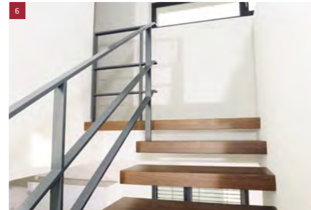
Detailansicht Flachstahlgeländer und oberer Treppenaustrittsbereich (Kragarmtreppe in Buche gebeizt)
