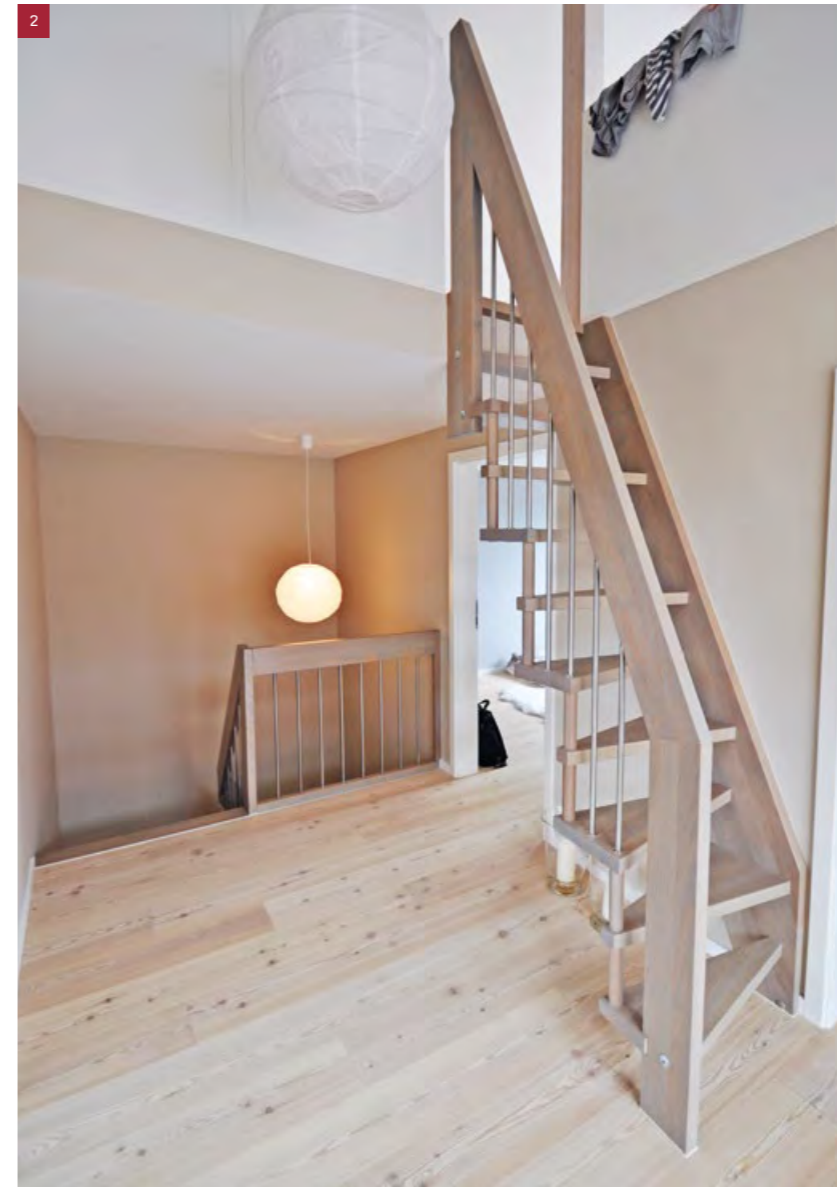
Sambatreppe in Buche grau gebeizt, mit Keilstufen, senkrechte Geländerstäbe in Edelstahl, Pfosten und Handlauf eckig
