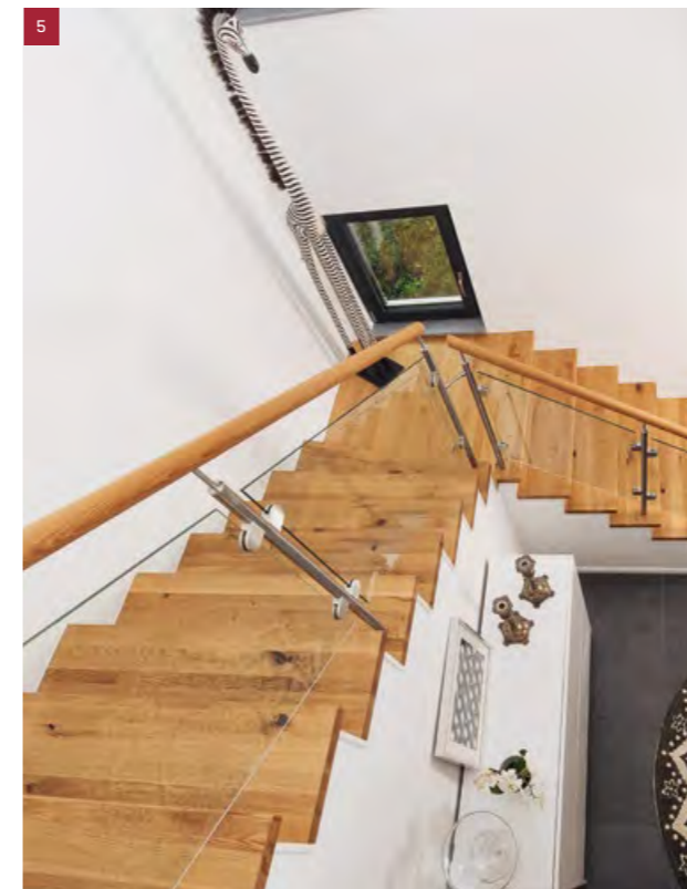
Detailansicht Treppenaufgang (Treppe mit Eckpodest in Wildeiche)
