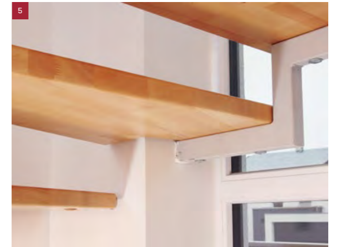
Detailansicht Stahlwangenübergang Fensterbereich
