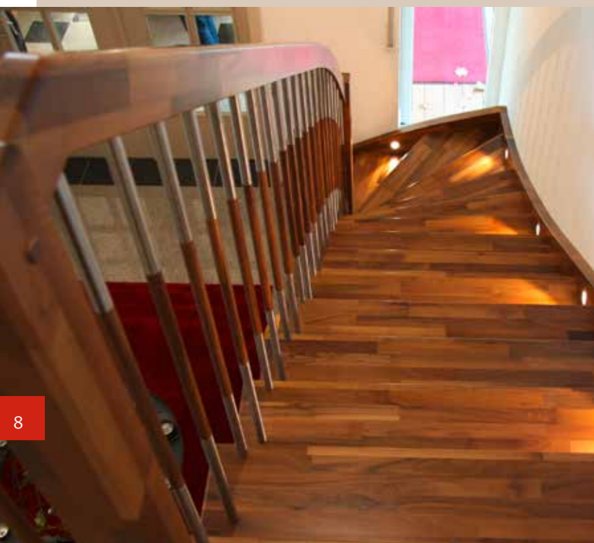
Zeitlose Wangentreppe aus gedämpftem Buchenholz mit eleganten, liegenden Wangen- und Handlaufkrümmlingen im Geländerbereich und 135°-Schrägen im äußeren Wangenbereich
