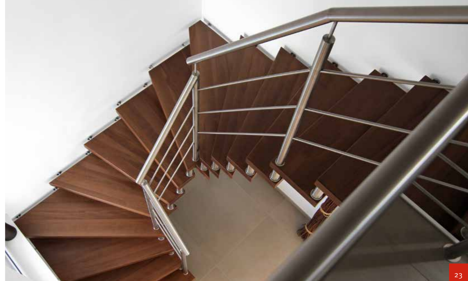
Moderne Tragbolzentreppe mit Trittstufen in Buche auf Nussbaum gebeizt und Edelstahlgeländer
