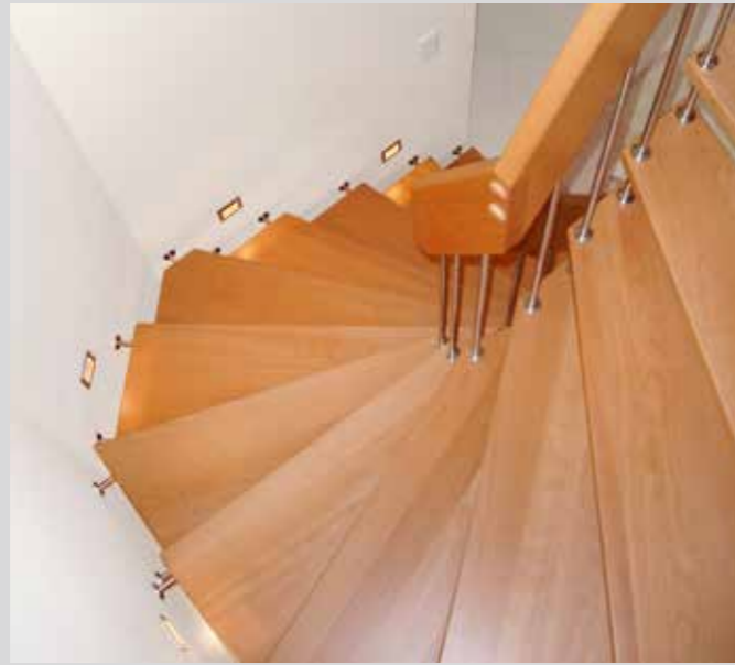
Gummigelagerte Edelstahlbolzen zwischen den Trittstufen und den angrenzenden Wänden erzielen sehr gute Werte hinsichtlich des Schallschutzes und lassen die Stufen quasi schweben
